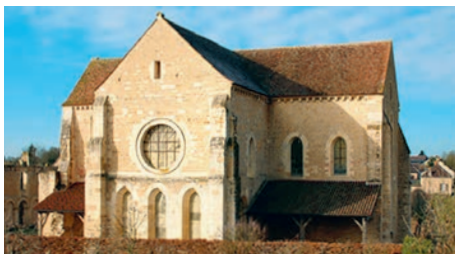
Vue générale de l'abbaye Notre-Dame de Fontmorigny, avant et après restauration.
